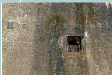
Caserne 3, détail de la façade
