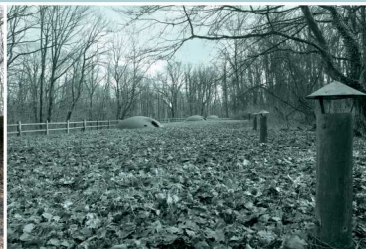
Batterie cuirassée : vue de trois tourelles tournantes et cheminées de ventilation des casemates
